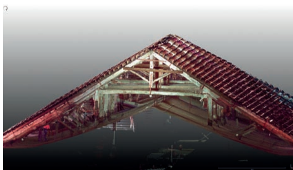
Rilievo 3D della capriata lignea settecentesca del Museo Archeologico di Napoli
